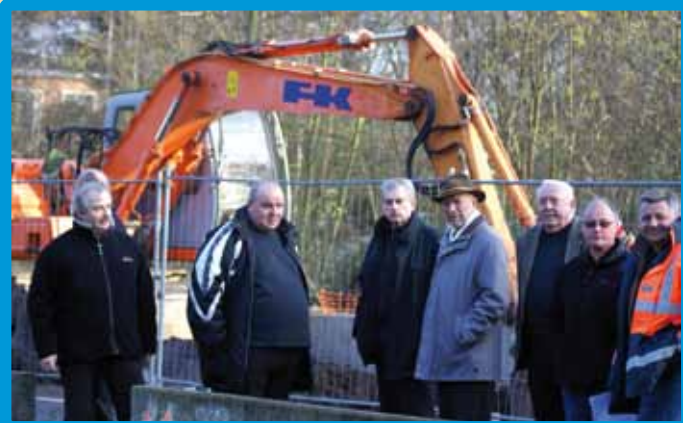
La commission en visite sur le chantier d'entrée de ville, rue de la Liberté.
