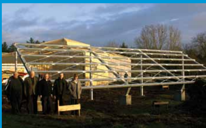
Regard sur l'armature qui va accueillir les panneaux photovoltaïques.
